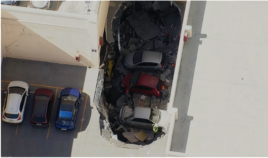
FIGURA 23 – Desabamento da laje do estacionamento do Osasco Plaza Shopping, em Osasco, região metropolitana de São Paulo, 2023 (Fonte: Poder 360 10 ).
